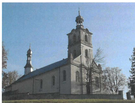
Fotografia 18. Widok na kościół parafialny pw. Wszystkich Świętych w Brzezinach.
