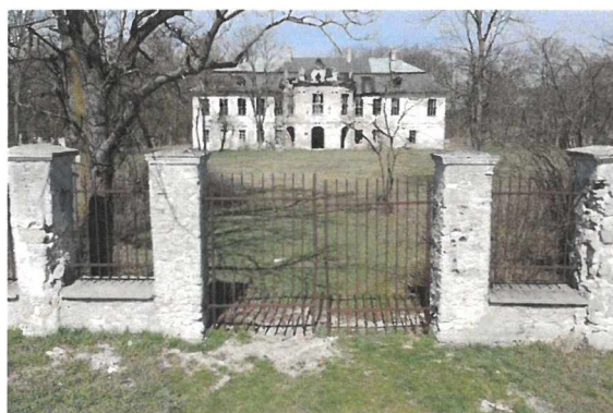
Fotografia 34. Widok na pałac w Śladkowie Dużym.
