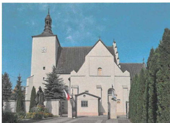
Fotografia 16. Widok na kościół pw. Św. Michała Archanioła.
