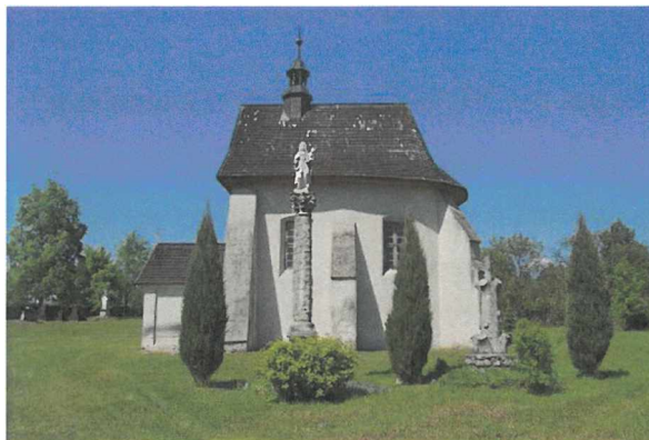
Fotografia 13. Kościół św. Trójcy w Chmielniku.
