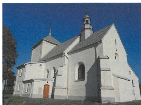
Fotografia 28. Widok na Kościół pw. Narodzenia NMP w Bolminie.
