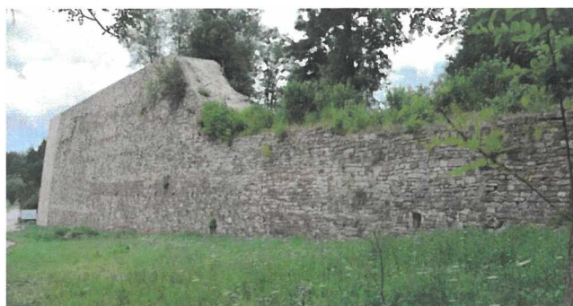
Fotografia 39. Widok na mur oporowy.
