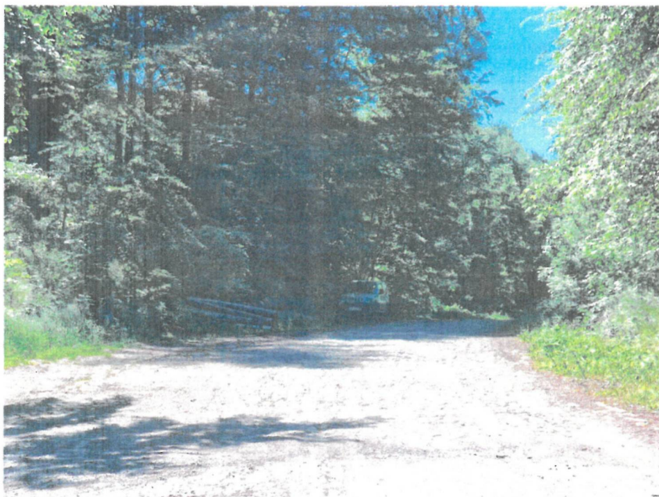
Zdj. Nr 3 Droga powiatowa nr 1424 T (leśniczówka Jeleniów)
