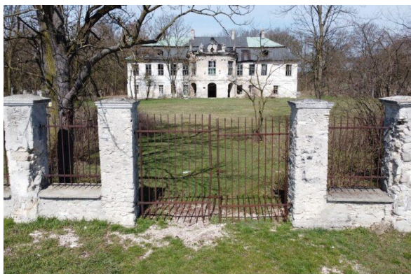
Fotografia 34. Widok na pałac w Śladkowie Dużym.
