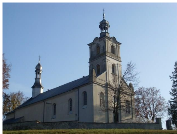
Fotografia 18. Widok na kościół parafialny pw. Wszystkich Świętych w Brzezinach.
