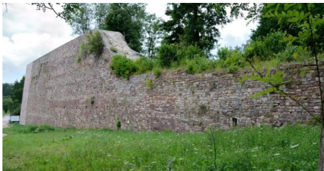
Fotografia 39. Widok na mur oporowy.
