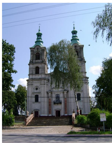
Fotografia 20. Widok na kościół pw. Narodzenia NMP w Piekoszowie.
