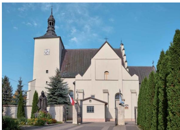
Fotografia 16. Widok na kościół pw. Św. Michała Archanioła.
