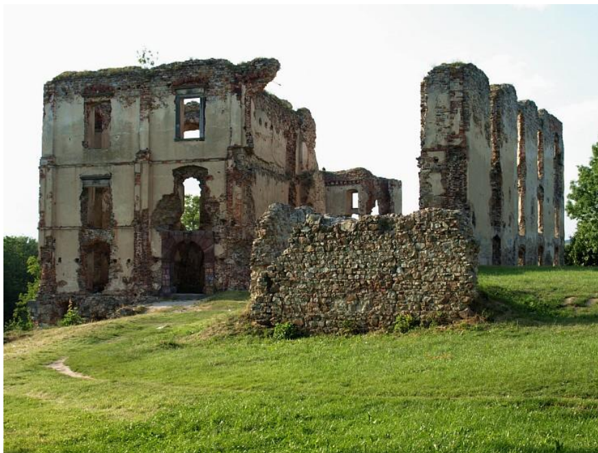
Fotografia 1. Widok od południa na ruinę zamku w Bodzentynie [5].
