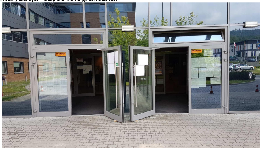
Fot. 1. Drzwi zewnętrzne
