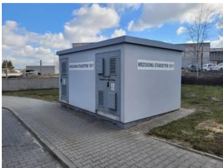
Instalacja fotowoltaiczna dla budynku Starostwa Powiatowego w Kielcach
